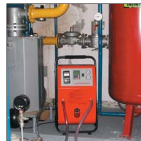
Удаление грязевых отложений из отопительных установок
